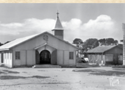
Église et maison provisoire du « bourg en bois »
